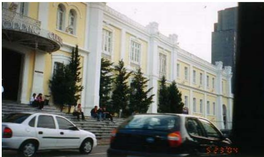
Fachada atual do antigo CPOR – Centro de Preparação de Oficiais da Reserva, da 5ª Região Militar na Praça Osvaldo Cruz, em Curitiba. Foto: SilviaC/2004.
